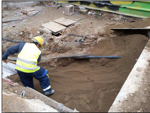
Cobriment de la rasa 1000 amb sauló
