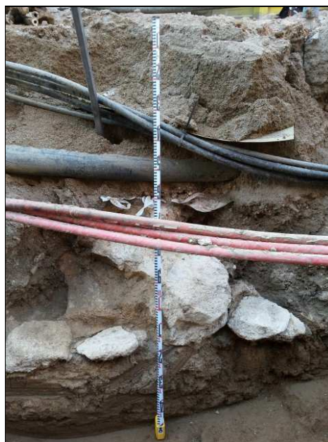
Estructura UE 1007 i l'estratigrafia que la cobreix
