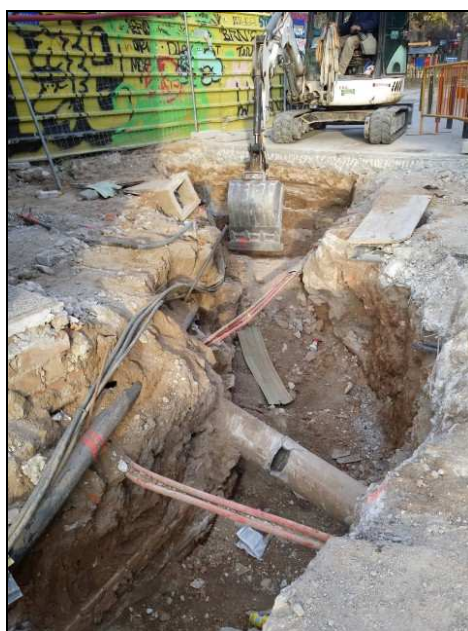
Imatge de la màquina rebaixant la zona on s'ha pogut fer el control arqueològic
