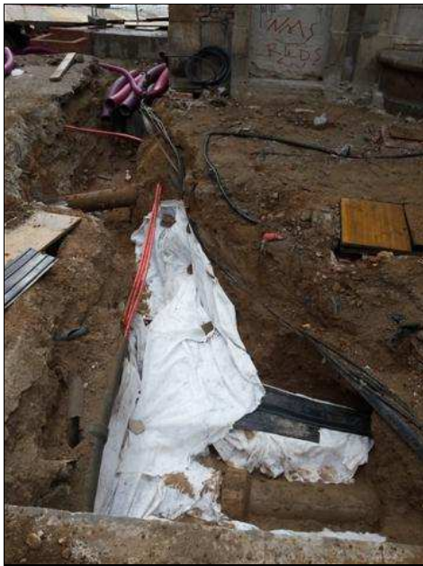
Cobriment i protecció de les restes amb geotèxtil
